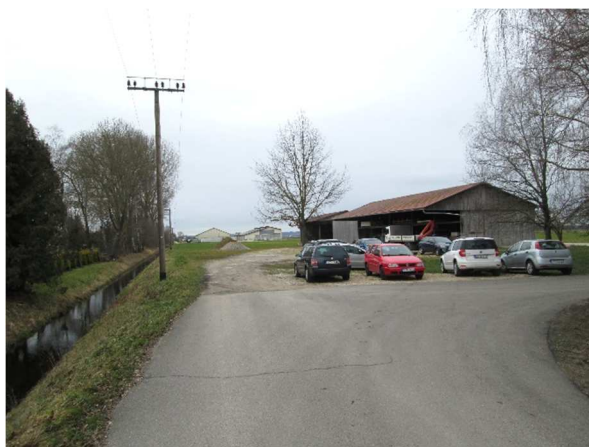
Abbildung 4: Blick entlang des Zeller Kanals nach Südwesten auf die ehemals landwirtschaftlich genutzte Lager- und Stallgebäude Fl. Nr. 550, Aufnahme vom 20.02.2020
