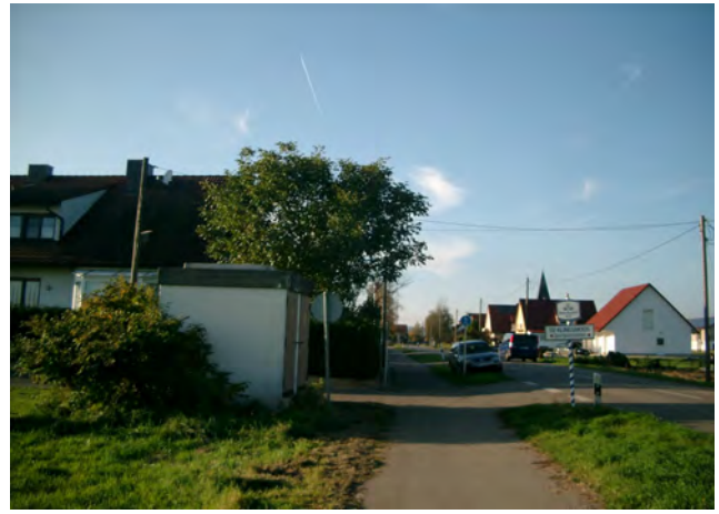
Foto 22 : Hinter Trafo unübersichtl. Ausfahrt vom Sportplatz zur Sandizeller Straße Vorschlag: Trafo verlegen
