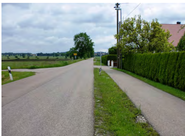
Foto 30: Geh und Radwegende Grimolzhausener Straße
