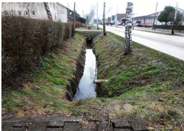
Foto 26: Straßengraben von Brücke Alte Schule Richtung Pöttmes Vorschlag: Verrohrung zum Bau eines Fußwegs
