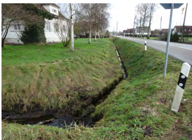
Foto 25: Straßengraben Kreuzung Ortszentrum – Sandizeller Straße, Richtung Süden Vorschlag: Verrohrung zum Bau von „Inseln“
