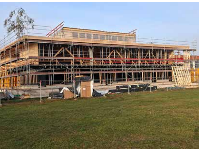
Der Rohbau des neuen Schulgebäudes
